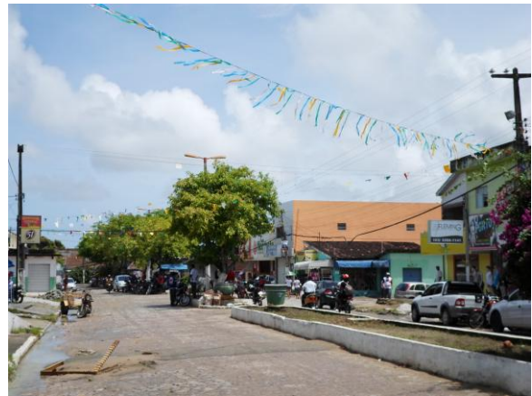
Ilustração 5 – Foto do trecho em obras/ Rua Salomão Veloso, Caaporã - Centro
